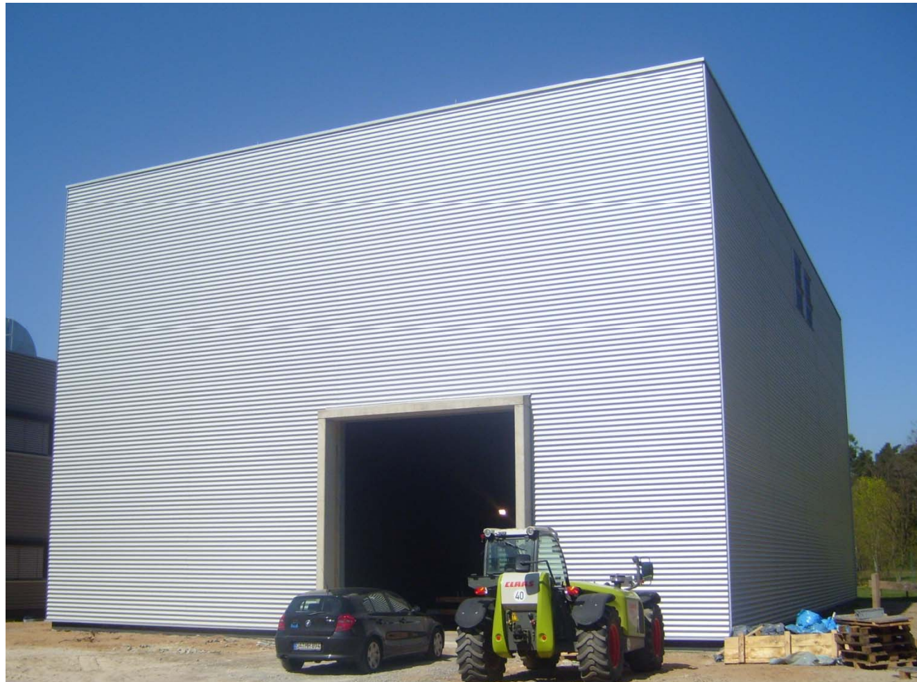
Rollenprüfstandsgebäude 70.22 im April 2010
